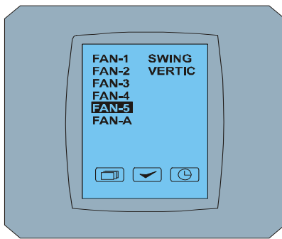
FAN SCREEN – FAN 5
